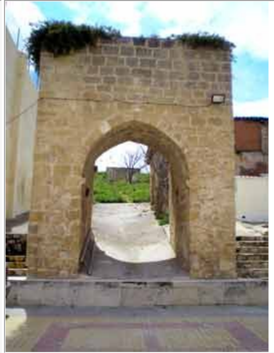
Puerta de la antigua muralla de Viana
