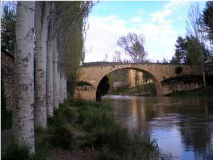
Puente sobre el Río Tajo
