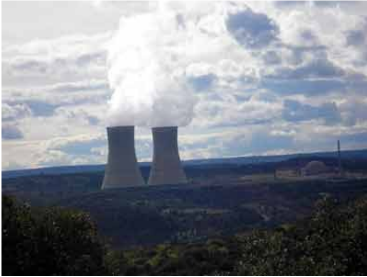
Chimeneas de la Central Térmica nuclear
