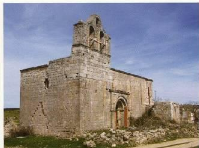
Vista exterior desde el lado suroeste
