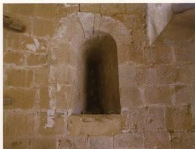
Ventana del interior del ábside
