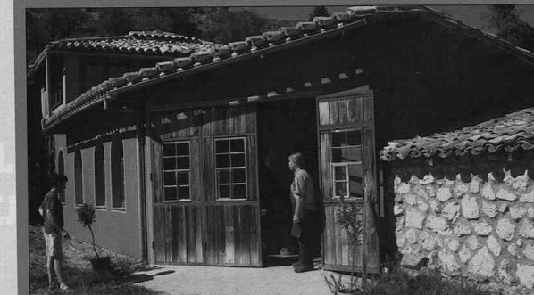
Vista exterior de la mielería de Christoph Gaupp Berghausen. Christoph ha rehabilitado esta vivienda de Torronteras, un lugar abandonado a donde llegó hace 30 años. El acceso al pueblo es a través de un camino forestal. No hay agua corriente ni red eléctrica, y esta se genera con placas solares y de un aerogenerador. Es un paraíso.
