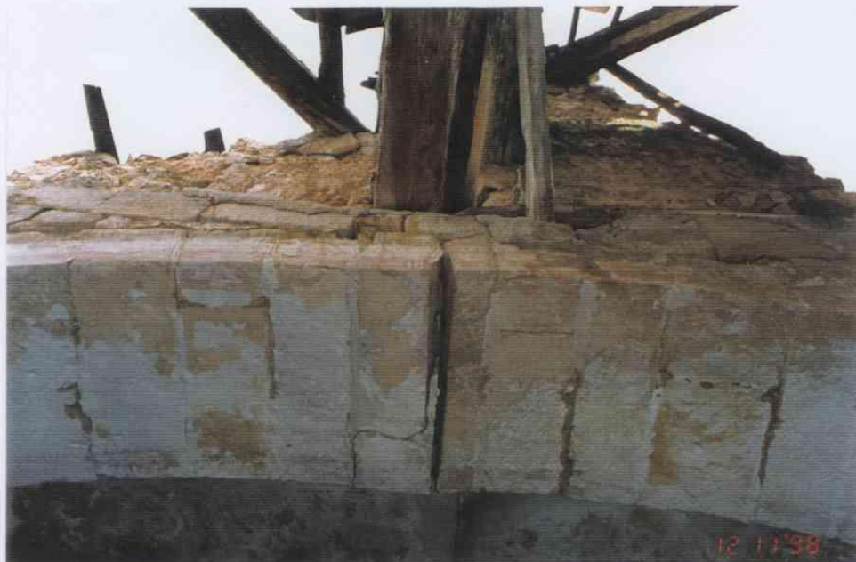
FOTO 15: Detalle del estado del arco de piedra de este tramo
