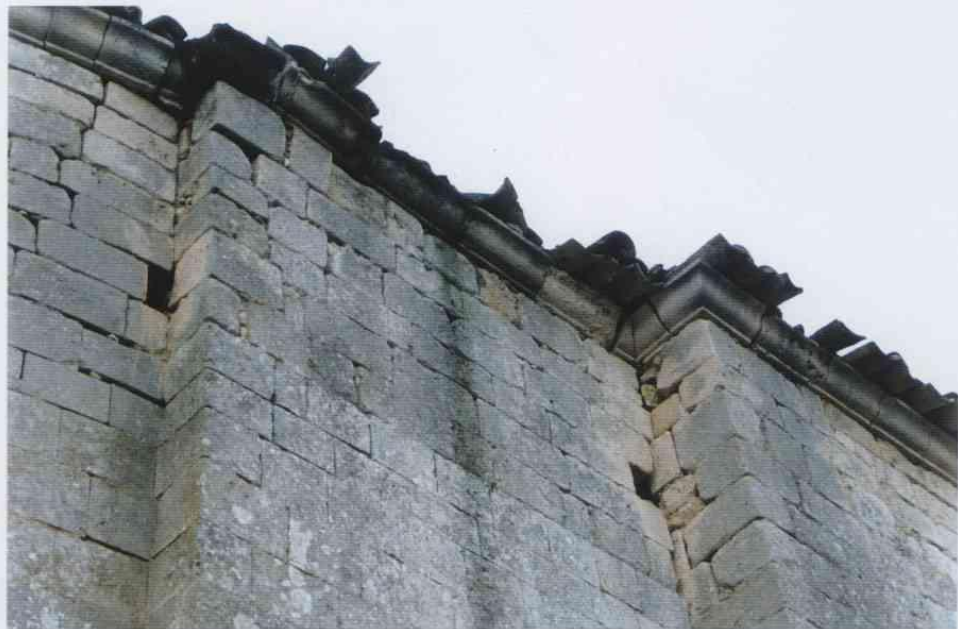
FOTO 4: Detalle del muro de sillería de las fachadas
